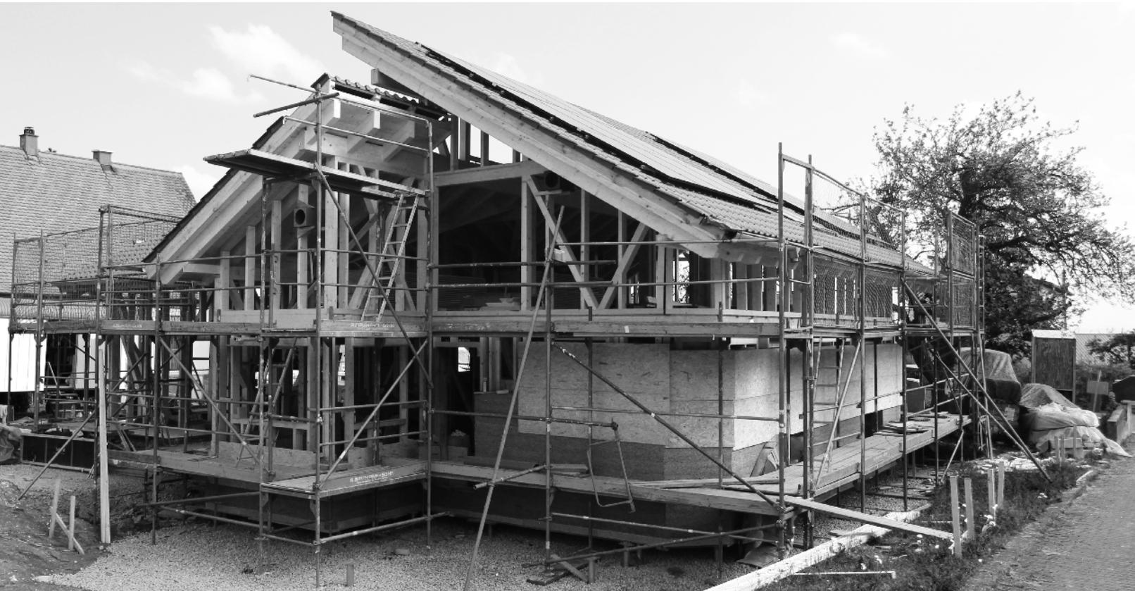
Eines unserer Kernanliegen ist die Vermeidung von fossilen Baustoffen und deren Ersatz durch nachwachsende, ressourcenschonende Alternativen. Durch den Einsatz von wiederverwendbaren Schraubfundamenten benötigen wir kein Stahlbeton-Fundament und minimieren die Bodenversiegelung. So bleibt die Wasseraufnahmekapazität des Grundstücks erhalten und ein höheres Niveau der Bodenplatte schützt vor Nässe von unten.
