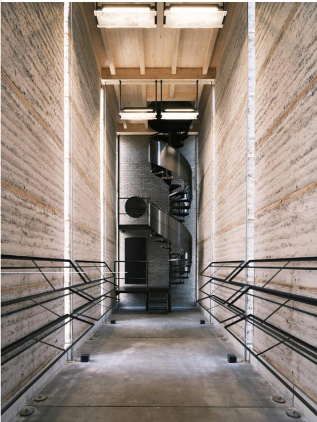
Stampflehm ist eine erdfeuchte Mischung aus Ton, Silt, Sand und Kies, die Schicht um Schicht und ohne weitere Zuschlagstoffe in eine Schalung oder auf eine formastabile Unterlage gestampft wird und nach direktem Ausschalen an der Luft austrocknet.
